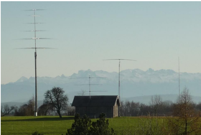
Bild 3-4: Eldorado auf dem Aargauer Jura: HB9CA, eine der besten DX- und Contest-Stationen in der Schweiz. Die weissen Pfähle sind für die Beverage-Empfangsantennen, rechts im Bild ist eine GP für 80m zu sehen.
